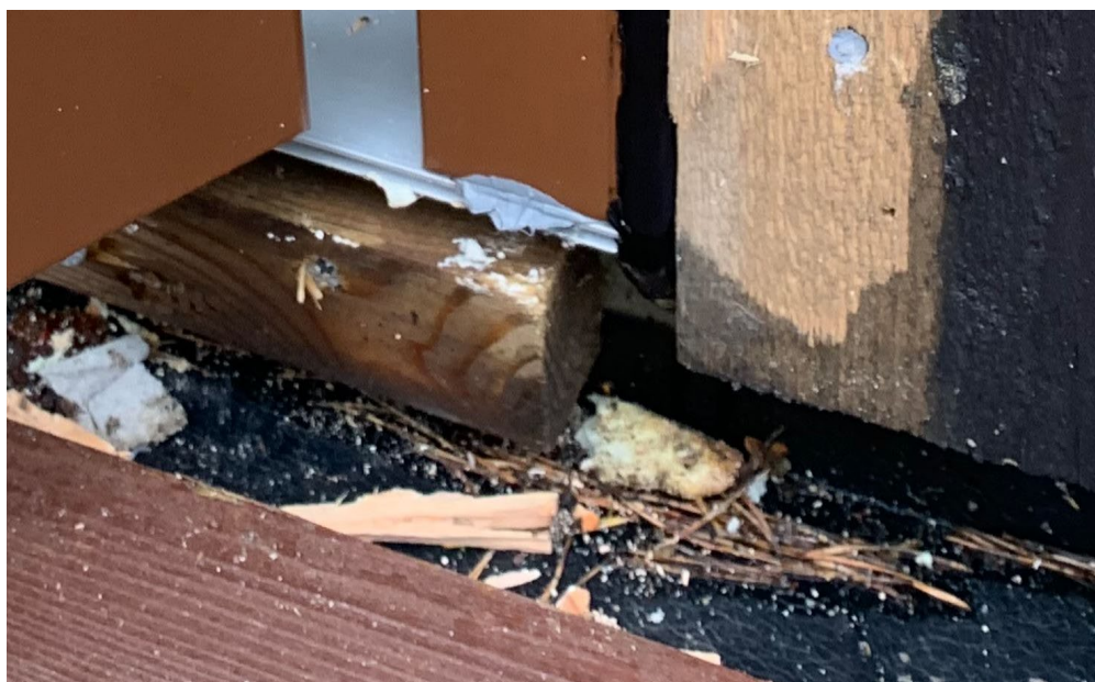
Her ser man beslag montert i 2014, dette ligger på terrassebordbjelkene og går oppover ringmurselementet og opp under døren. Utenpå trelekten som er under aluminiums terskelen er det
