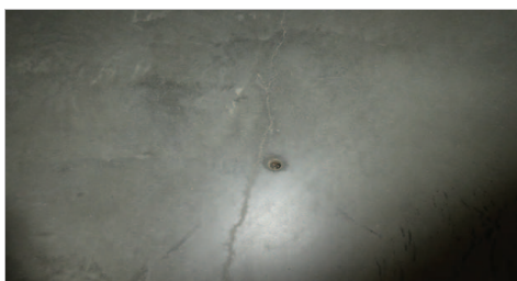
Borret hull i dekke garasjeanlegg for å fjerne overflatevann.
