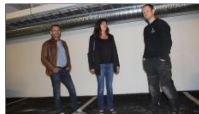
SNART FERDIG: Daglig leder Kjartan Reime i AVE, styreleder Sameiet Meto og Erlend Ueland i AVE i parkeringsanlegget som tilrettelegges for lading av EL-biler. FOTO: Trude Håland
