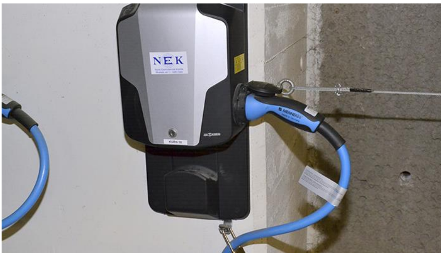
Mode 3 På-vegg-lader med Type 2 kontakt (Foto: Leif T. Aanesen/NEK)
