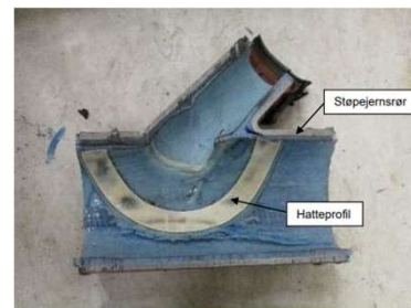
Rør som er rørfornyet - gjennomskåret.
