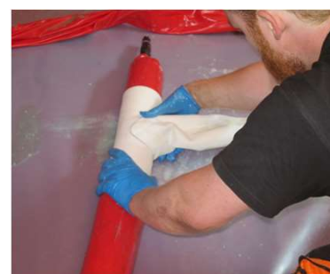
Klargjøring for montering av strømpe.
