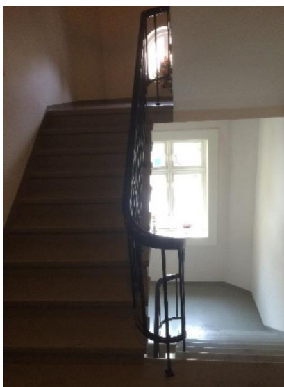
Trapperom med vindu for åpning
