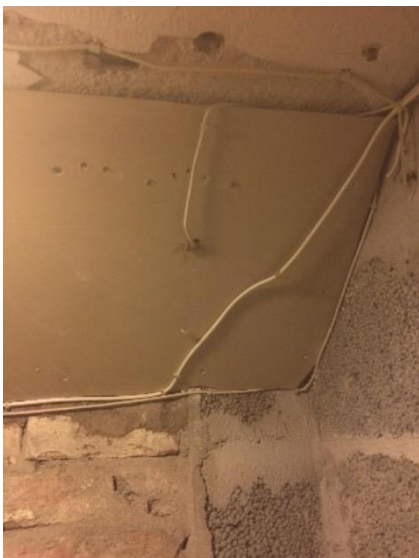
Utetthet i overgang/skjøt loft/leil.h.
