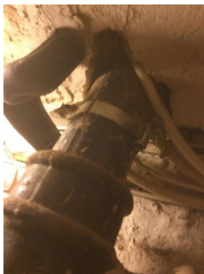
Utette rørgjennomføringer - tak kjeller
