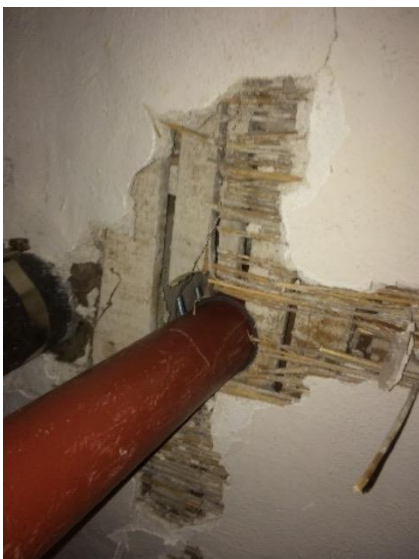
Utette rørgjennomføringer - tak kjeller
