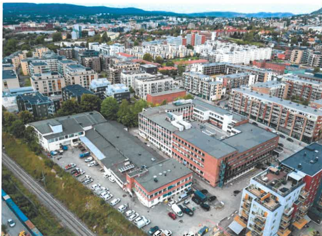
Figur 3: Dagens situasjon. Bildet viser eksisterende bygninger i Lørenveien 51 og Lørenvangen 14.
