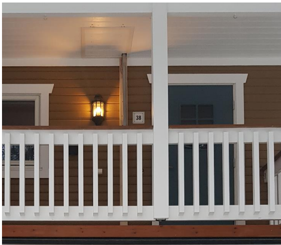
Luke og rømningsstige, sett fra bakken.
