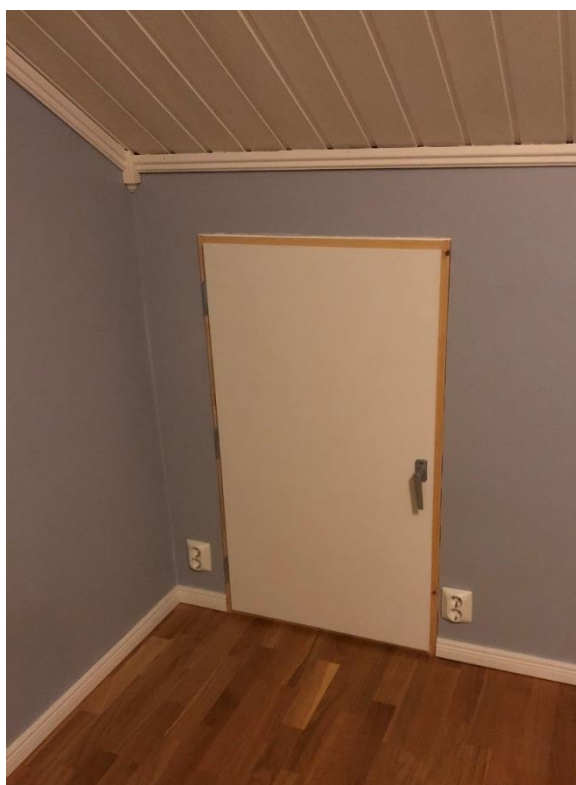
Rømningsdør fra soverom loft, ut til kaldloft over inngangsparti.
