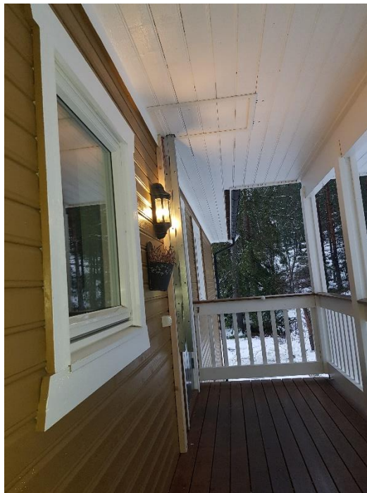
Luke og rømningsstige sett fra trappen.
