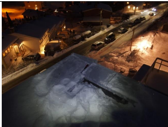
Bilde 5. Oversiktsbilde parapet.
