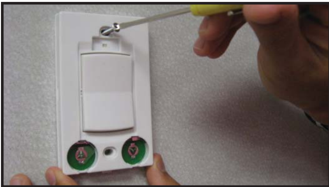
Figur 2 Montere trådløs veggbryter
