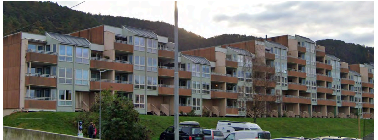
Dagens bebyggelse - fasade stue/kjøkken
